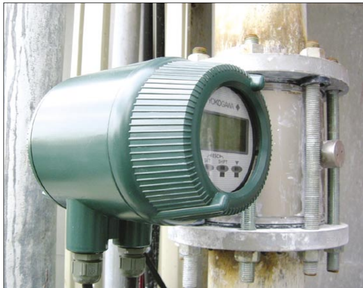
Obr. 1. Indukční průtokoměr ADMAG AXF měří průtok suspenze vápence a vody
